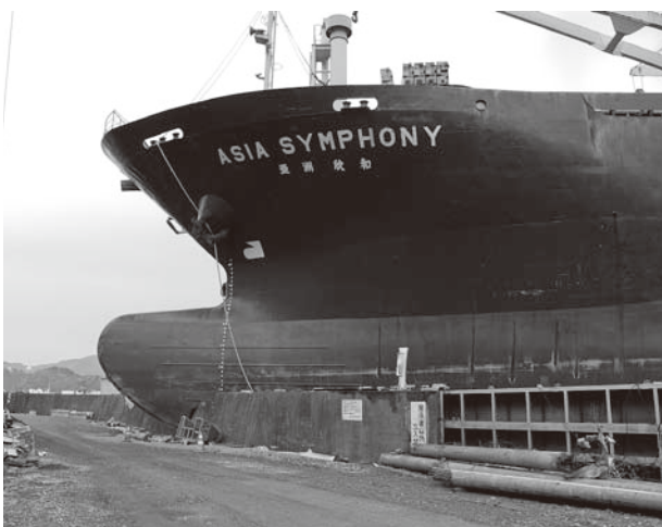
▲釜石港護岸を突き破る大型船
